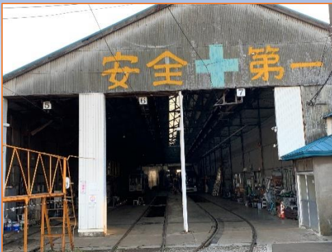
函館大火後に建てられた車庫
