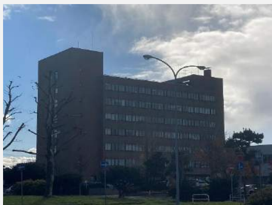
函館地方合同庁舎の建物の外観
