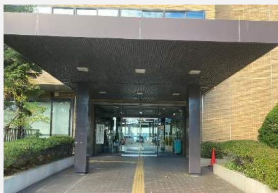
地方合同庁舎の建物の入り口
